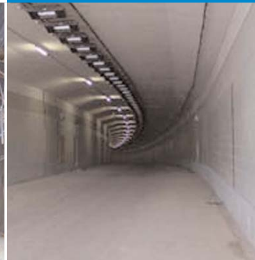
Seitwende Tunnel, Netherlands
